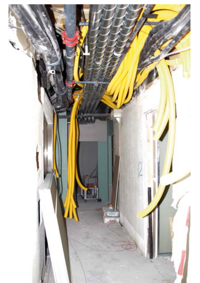
Korridor im Rohbau
